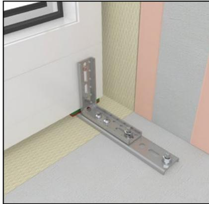
Verbindungswinkel an die Konsole und das Anschlussprofil schrauben
