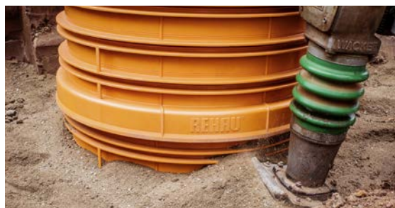
Fig. 05-31 Rellenado y compactación del entorno del pozo
