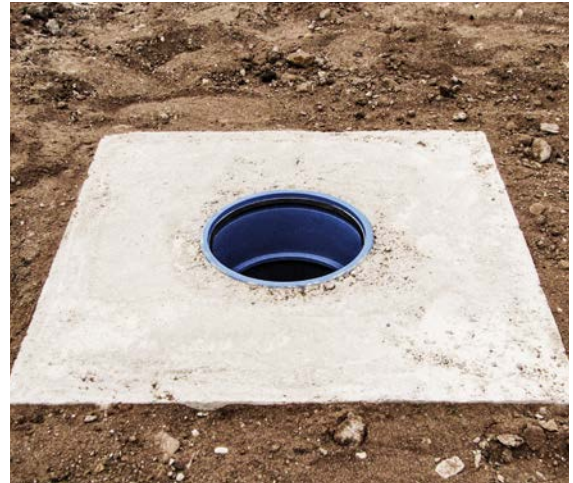
Fig. 05-1 Zócalo de hormigón con manguito doble copa
