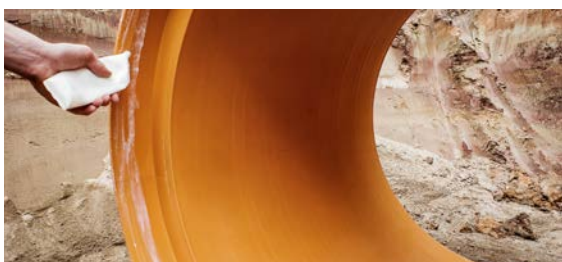
Fig. 05-29 Aplicación de una capa uniforme de lubricante en la copa del anillo del pozo
