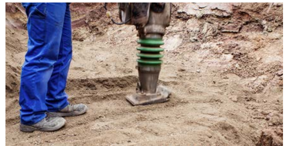
Fig. 05-25 Preparar la zona de apoyo para el fondo del pozo
