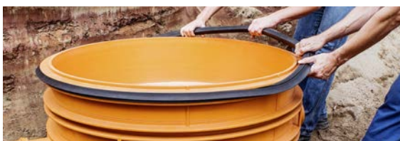
Fig. 05-27 Colocación de la junta de pozo
