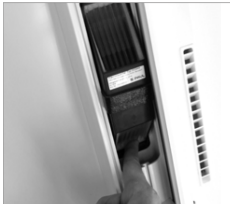
Herausziehen des Wärmetauschers
