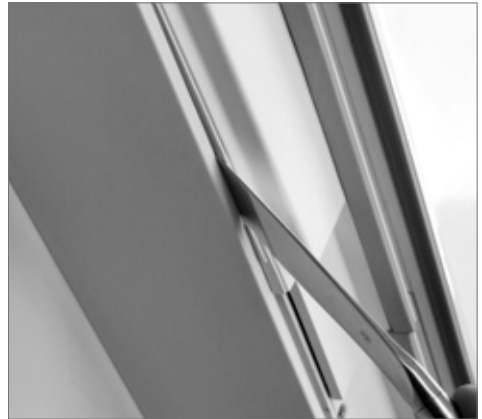
Öffnen des Revisionsdeckels
