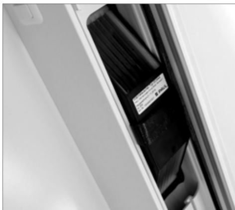
Ausrichten des Wärmetauschers
