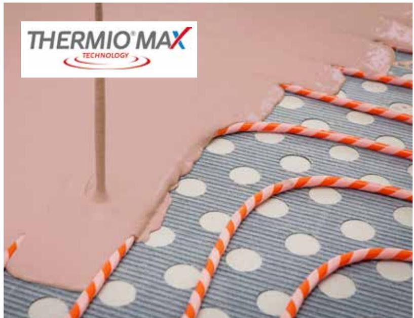
\* con 10 mm de mortero autonivelante Thermio®Max de Anhydritec por encima del tubo. Para más información contacte con su delegado REHAU.
