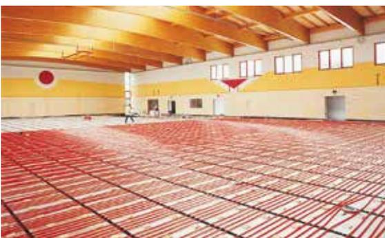
**Calefacción para suelos flotantes: pavimento calefactado— para disfrutar de temperaturas agradables en los pabellones**
