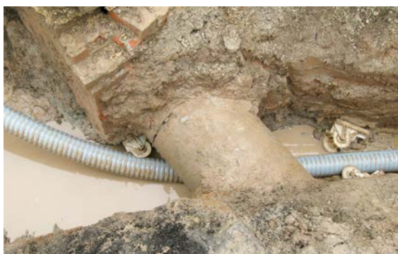
Fig. 07-23 Fácil colocación, gracias a la flexibilidad para seguir trazados
