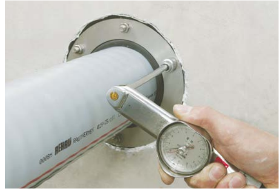
Fig. 05-12 Montaje con llave dinamométrica
