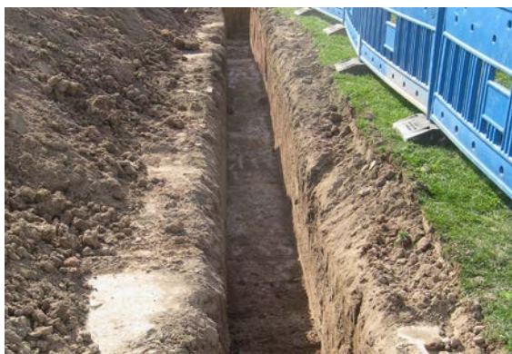
Fig. 07-1 Fondo de la zanja adecuado
