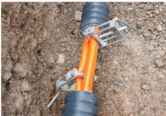
Fig. 07-31 Pinzamiento del tubo interno DUO
