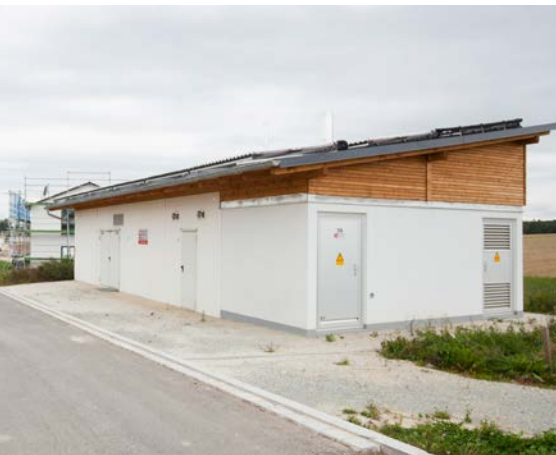
Fuente de calor/central de calefacción
