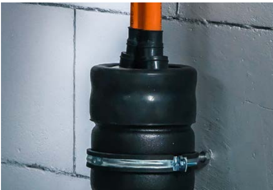
Fig. 05-23 Terminación de tubo con capuchón de goma
