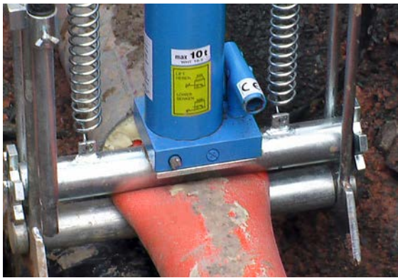
Fig. 07-30 Pinzamiento del tubo interno UNO
