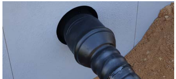
Fig. 05-16 Ejemplo de montaje Set para entrada en vivienda con tubo termorretráctil y junta modular
