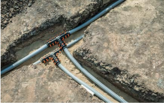
Fig. 07-4 Instalación en zanja abierta
