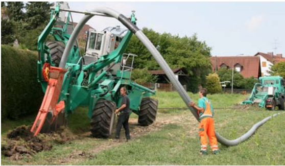
Fig. 07-8 Colocación con arado para tuberías
