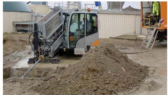
Fig. 07-10 Colocación con aparato de perforación horizontal dirigida
