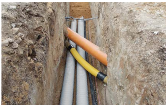
Fig. 07-21 Cruzamiento por debajo de tuberías
