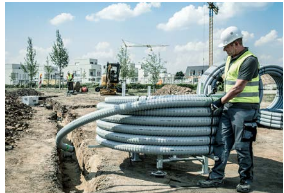
Fig. 07-33 Desbobinador horizontal estacionario al final de la zanja
