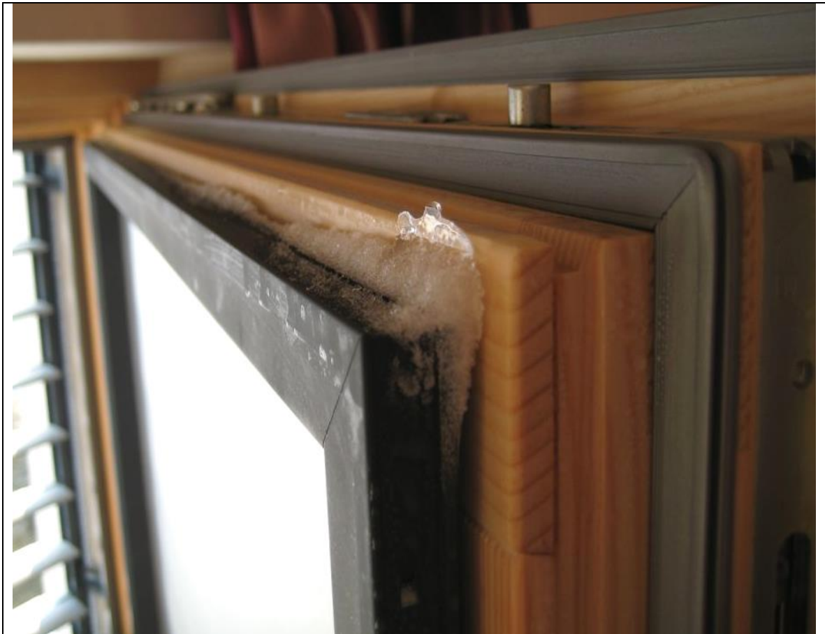
Eisbildung bei Holz-Aluminium-Fenstern ist keine Seltenheit
